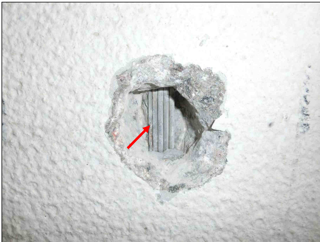
Foto 5: Detail sondy S5, předpínací výztuž nosník KA73, 7. nosník od návodní strany, spodní líc. Na předpínací výztuži nebyla nalezena koroze. Kanálek zcela vyplněn injektážní směsí. Krytí předpínací výztuže cca 45 mm. Poloha viz Příloha 1.
