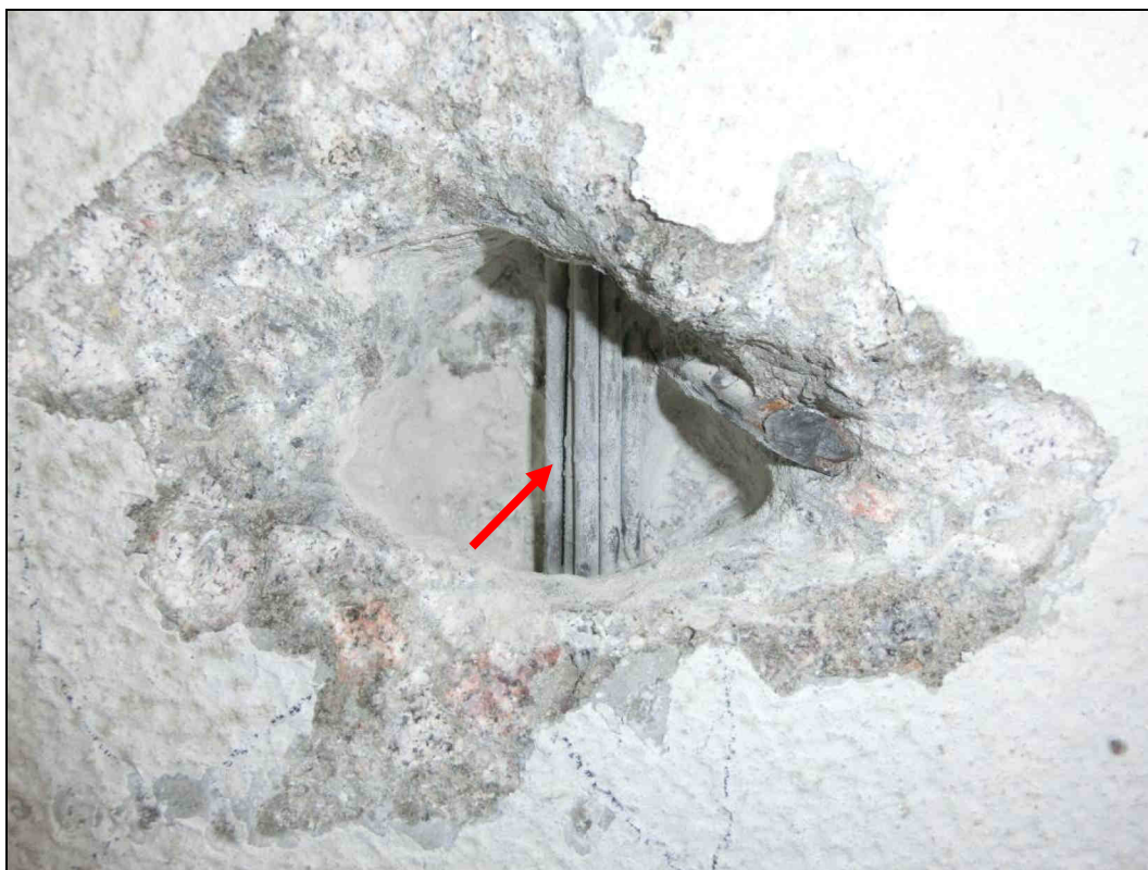
Foto 2: Detail sondy S1, předpínací výztuž nosník KA73, 10. nosník od návodní strany, spodní líc. Na předpínací výztuži nebyla nalezena koroze. Kanálek zcela vyplněn injektážní směsí. Krytí předpínací výztuže cca 45 mm. Poloha viz Příloha 1.
