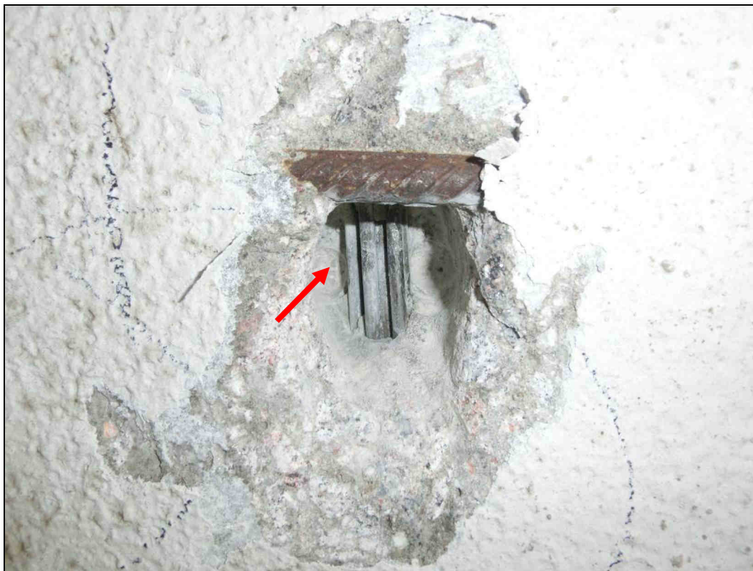
Foto 1: Detail sondy S1, předpínací výztuž nosník KA73, 11. nosník od návodní strany, spodní líc. Na předpínací výztuži nebyla nalezena koroze. Kanálek zcela vyplněn injektážní směsí. Krytí předpínací výztuže cca 40 mm. Poloha viz Příloha 1.
