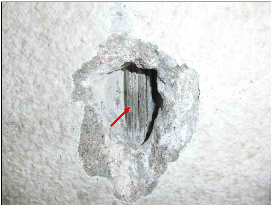
Foto 3: Detail sondy S3, předpínací výztuž nosník KA73, 9. nosník od návodní strany, spodní líc. Na předpínací výztuži byla nalezena povrchová koroze. Kanálek zcela vyplněn injektážní směsí. Krytí předpínací výztuže cca 40 mm. Poloha viz Příloha 1.
