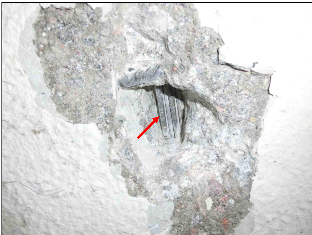
Foto 14: Detail sondy S14, předpínací výztuž nosník KA73, 5. nosník od návodní strany, spodní líc. Na předpínací výztuži nebyla nalezena koroze. Kanálek zcela vyplněn injektážní směsí. Krytí předpínací výztuže cca 45 mm. Poloha viz Příloha 1.
