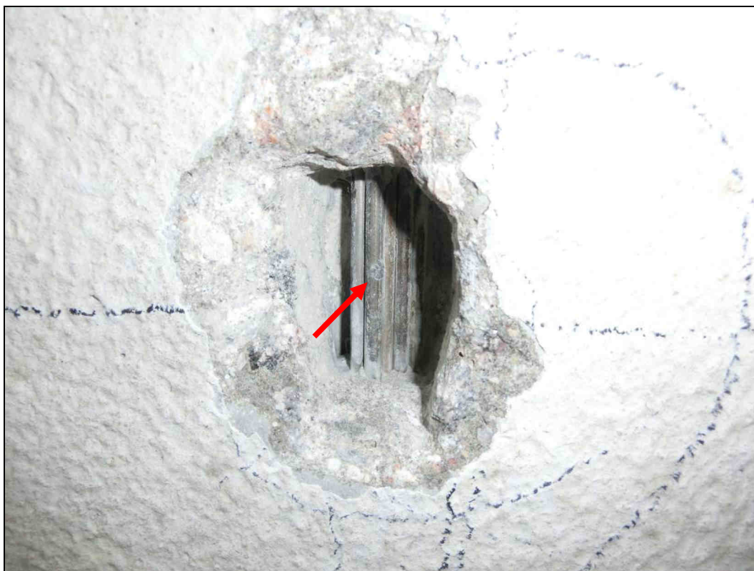
Foto 9: Detail sondy S9, předpínací výztuž nosník KA73, 3. nosník od návodní strany, spodní líc. Na předpínací výztuži nebyla nalezena koroze. Kanálek zcela vyplněn injektážní směsí. Krytí předpínací výztuže cca 35 mm. Poloha viz Příloha 1.
