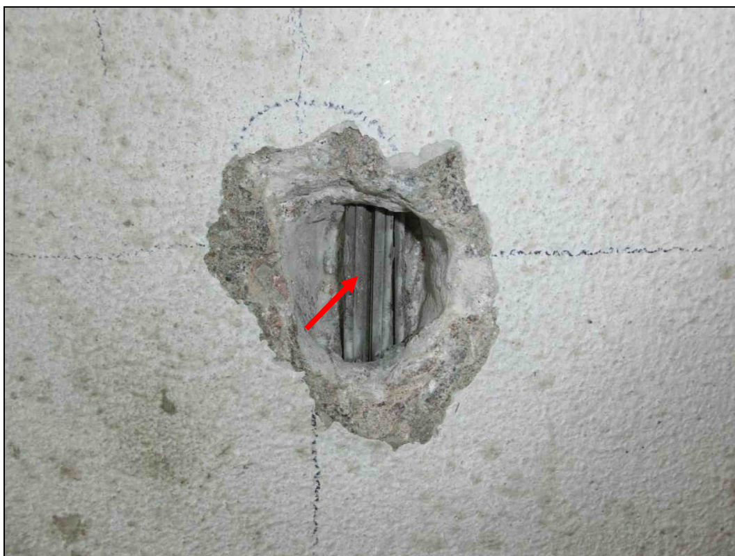
Foto 10: Detail sondy S10, předpínací výztuž nosník KA73, 2. nosník od návodní strany, spodní líc. Na předpínací výztuži nebyla nalezena koroze. Kanálek zcela vyplněn injektážní směsí. Krytí předpínací výztuže cca 45 mm. Poloha viz Příloha 1.
