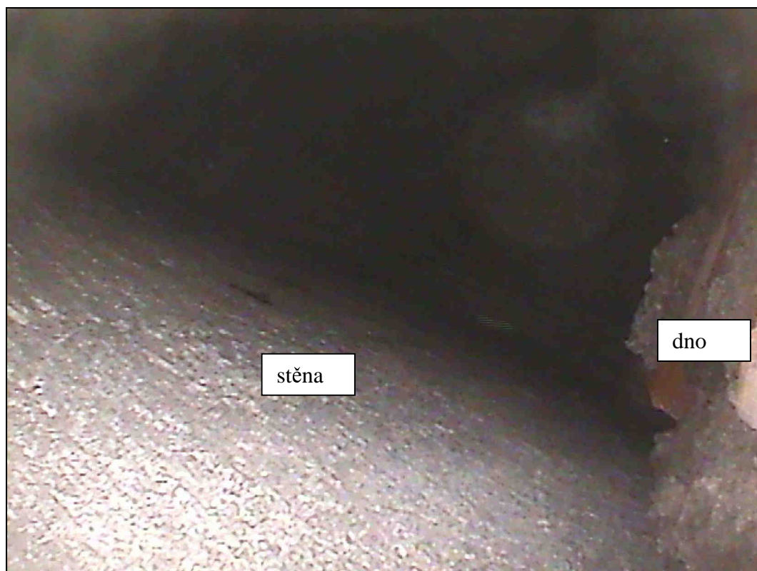
Foto 1: Detail vnitřního povrchu komory KA nosníku. Sonda 1, v okolí destruktivní sondy k předpínací výztuži S1, 11 nosník od návodní strany mostu. Lokální koroze měkké výztuže. Vnitřní povrch komory suchý.
