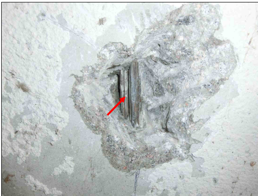
Foto 15: Detail sondy S15, předpínací výztuž nosník KA73, 8. nosník od návodní strany, spodní líc. Na předpínací výztuži byla nalezena povrchová koruze. Kanálek zcela vyplněn injektážní směsí. Krytí předpínací výztuže cca 40 mm. Poloha viz Příloha 1.
