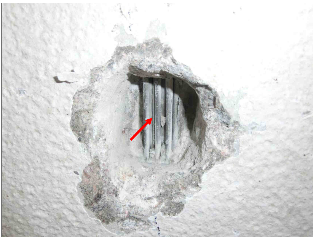
Foto 8: Detail sondy S8, předpínací výztuž nosník KA73, 4. nosník od návodní strany, spodní líc. Na předpínací výztuži nebyla nalezena koroze. Kanálek zcela vyplněn injektážní směsí. Krytí předpínací výztuže cca 45 mm. Poloha viz Příloha 1.
