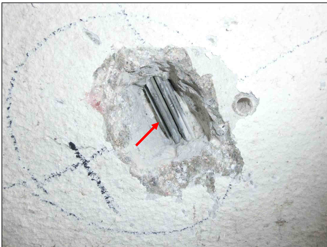
Foto 13: Detail sondy S13, předpínací výztuž nosník KA73, 3. nosník od návodní strany, spodní líc. Na předpínací výztuži nebyla nalezena koroze. Kanálek zcela vyplněn injektážní směsí. Krytí předpínací výztuže cca 40 mm. Poloha viz Příloha 1.
