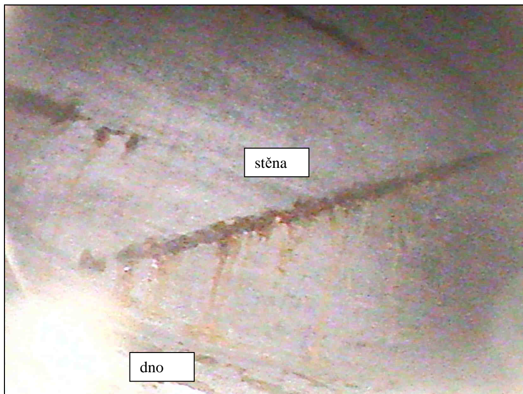
Foto 6: Detail vnitřního povrchu komory KA nosníku. Sonda 5, v okolí destruktivní sondy k předpínací výztuži S12, 1 nosník od návodní strany mostu. Lokální koroze měkké výztuže. Vnitřní povrch komory suchý. Neaktivní stopy po zatékání.
